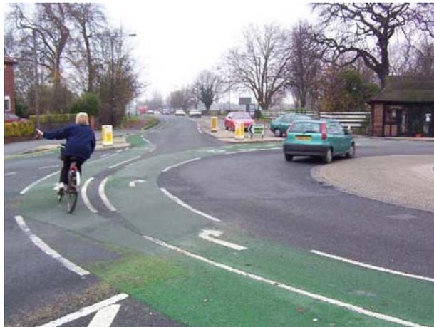
*Imagen 20. Carril bici exterior sobre la calzada de glorieta*
