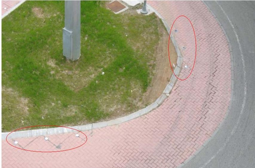
*Imagen 57. Detalle de las balizas luminosas proyectadas por Vectio en las turboglorietas de Castro Urdiales (Principado de Asturias).*
