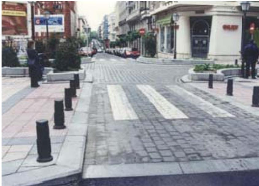
*Imagen 36. Meseta o plataforma elevada en intersección. P.lan Local de seguridad vial (Generalitat de Catalunya)*
