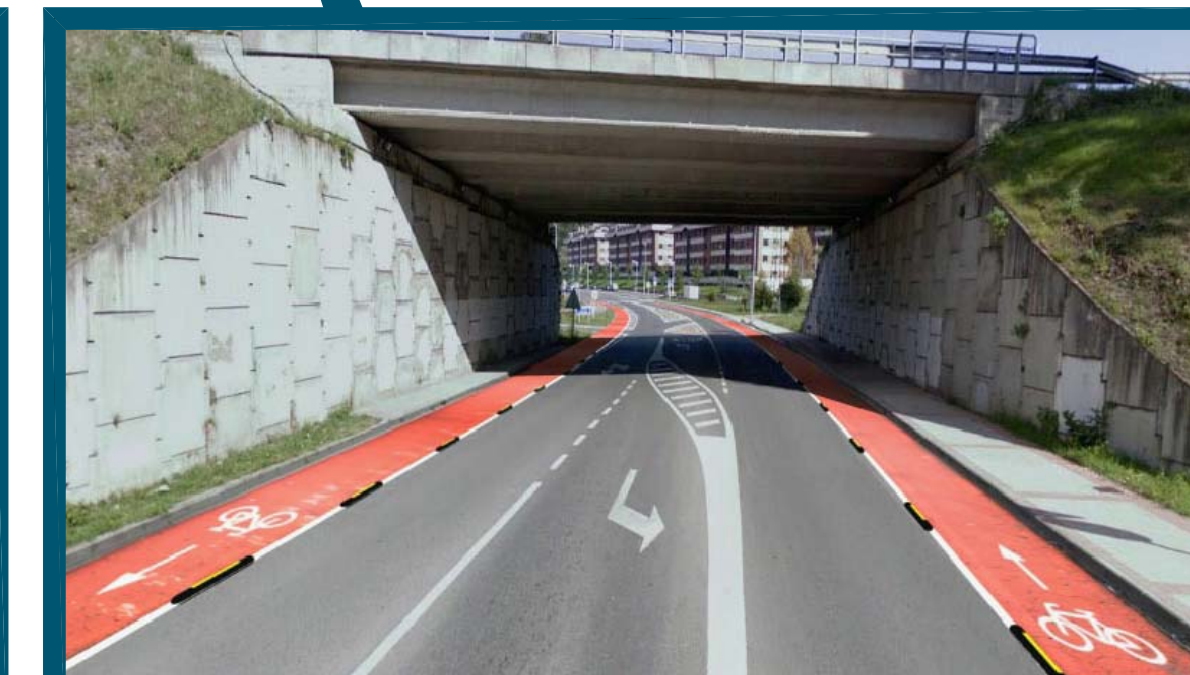
Carretera a Samano / Puente A-8
