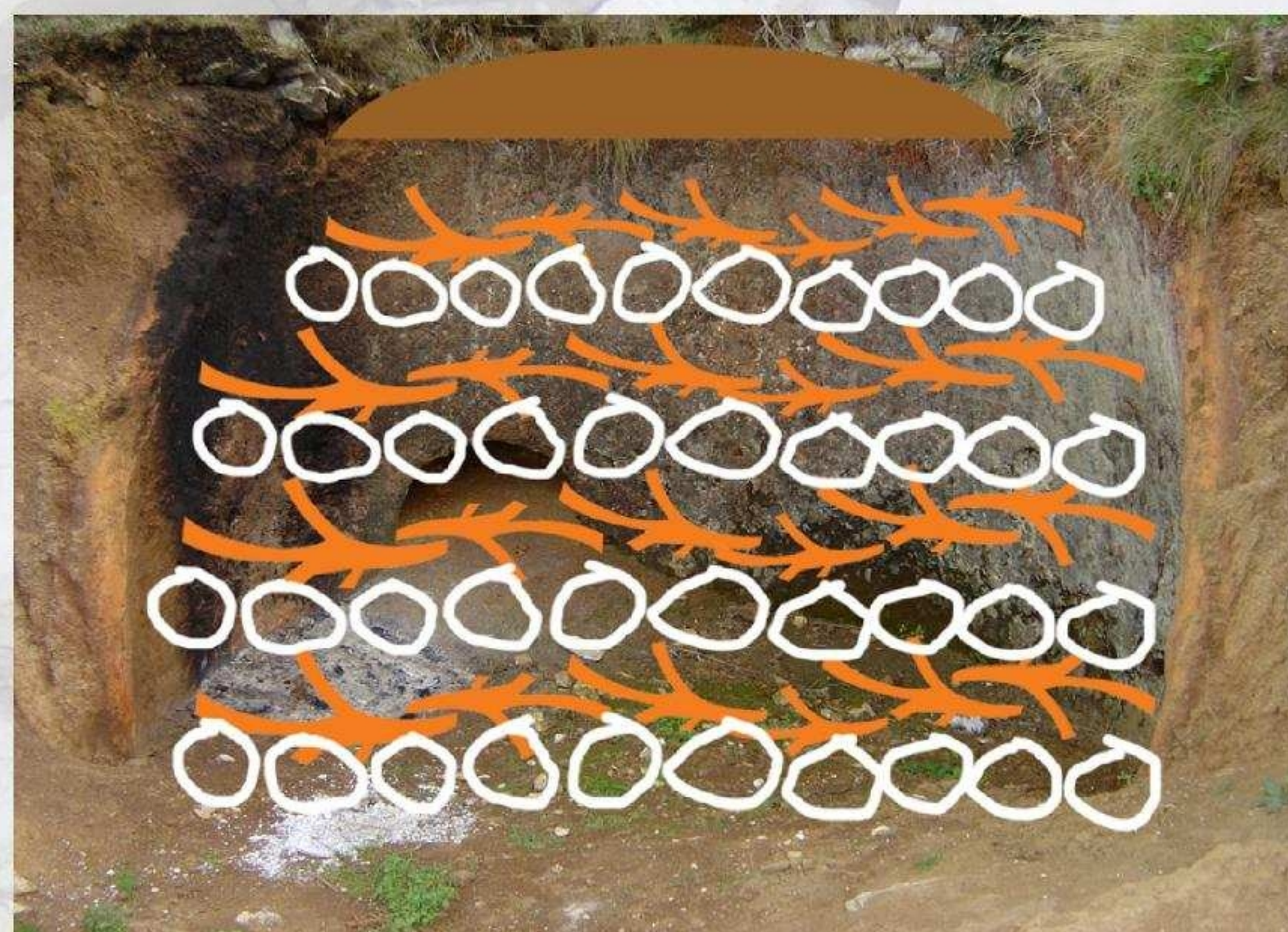
Arriba: Estructura interior del calero.
